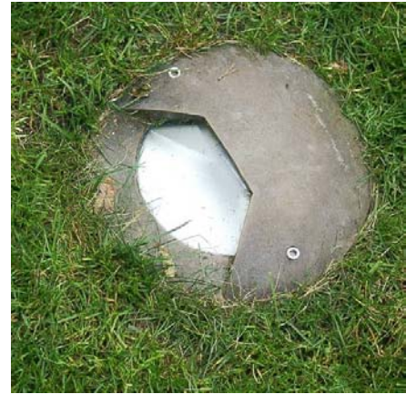
Abb. 57: Bodenstrahler zur Bestrahlung der Mauern
